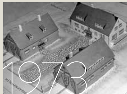
Der Stifterverband bezieht seinen eigens für ihn errichteten Hauptsitz am Brucker Holt 56-60 in Essen-Bredeney. Zuvor war die Geschäftsstelle an anderen Standorten in Essen untergebracht.
