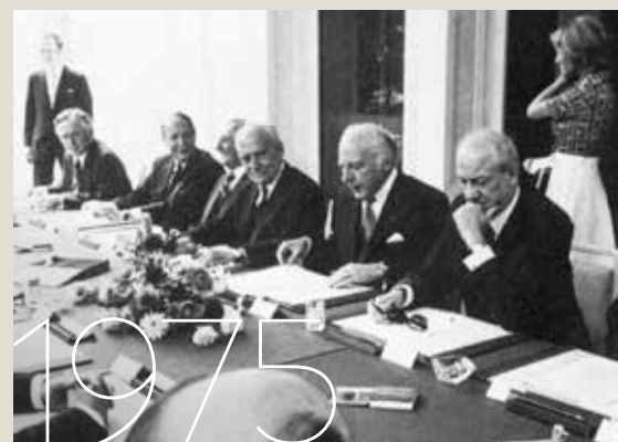
Bundespräsident Walter Scheel (2.v.r.) brachte die Leistungen des Stifterverbandes vor der Arbeitsgemeinschaft deutscher Stiftungen auf den Punkt: „Der Raum der Freiheit der Wissenschaft wird durch die privaten Stiftungen erheblich erweitert und, im gewissen Maße, gesichert.“
